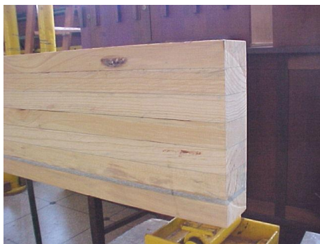
Figura 1: Viga de MLC reforçada com fibra de vidro
